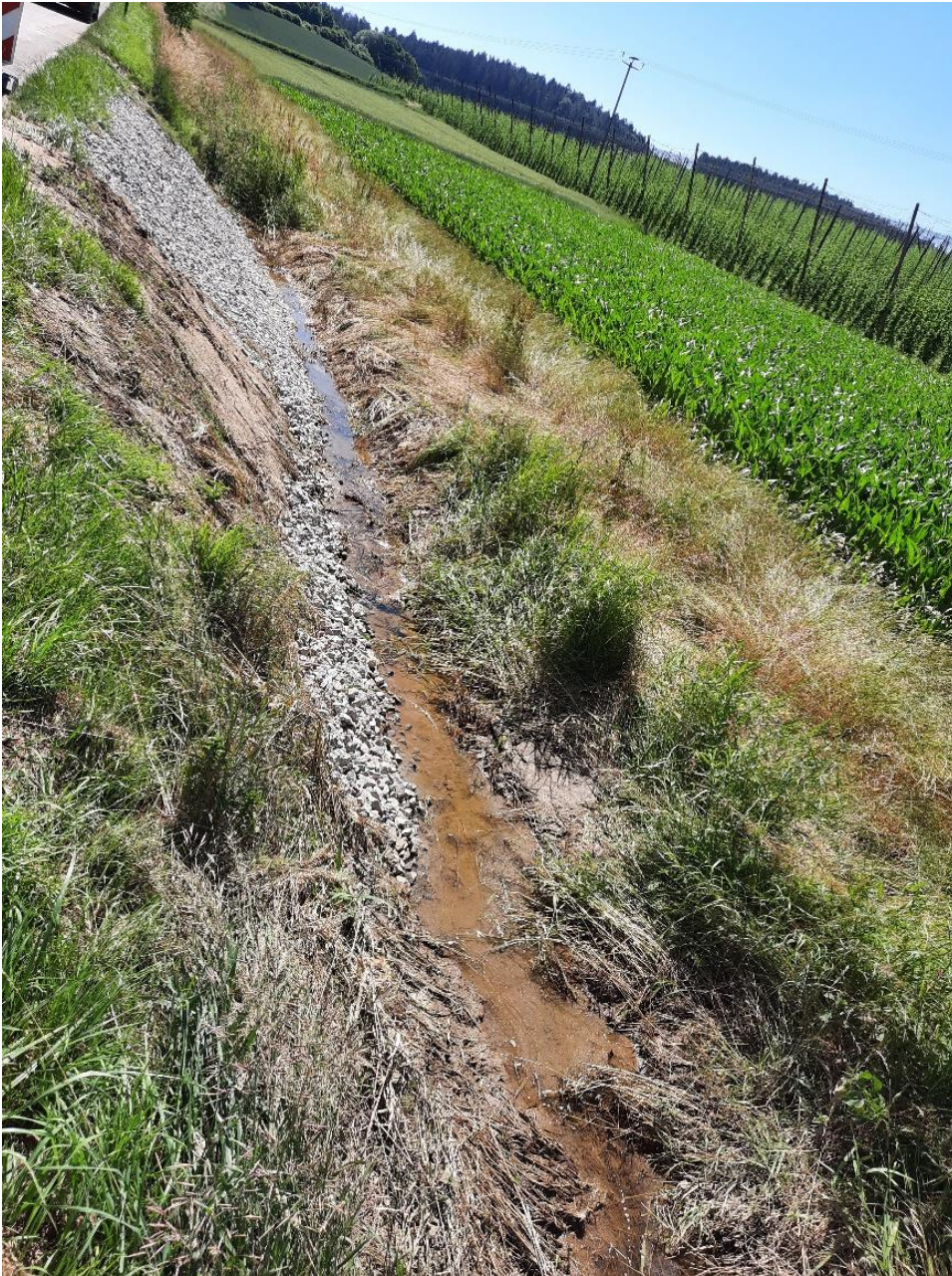
Aktueller Zustand: Versetzter Verlauf des Auerkofener Grabens und verbreiterte Straßenböschung (Detail).
