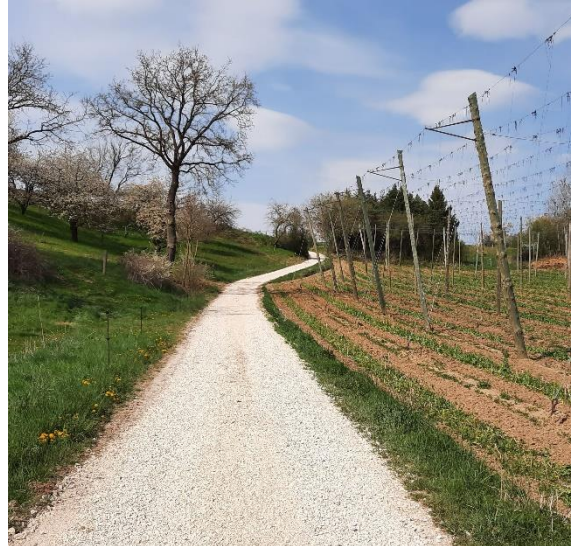
Dieses Beispiel könnte Schule machen: Geschotterter Feldweg in Oberwangenbach
