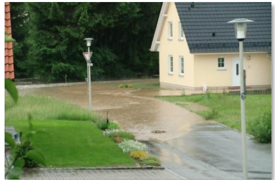
Bilder wie diese im Bereich der Spitzauer Straße in Walkertshofen sollten zukünftig der Vergangenheit angehören. Das verspricht ein Gutachten mit dem Bau des Hochwasserrückhaltebeckens
